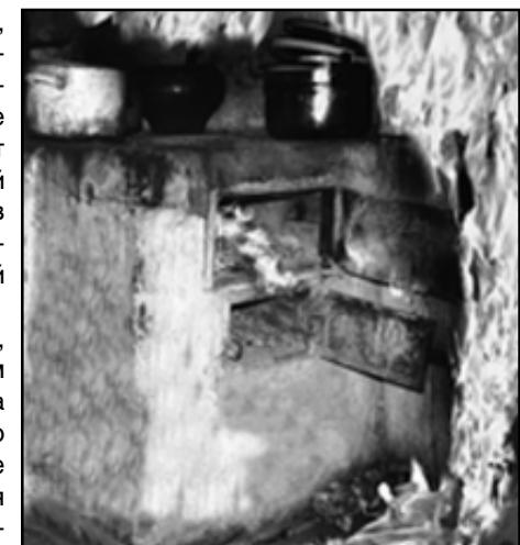
пламя следует помнить следующие требования: печи и другие отопительные приборы должны иметь противопожарные разделки (отступки) от горючих конструкций, а также предтопочный лист размером 0,5 x 0,7 м на деревянном полу или полу из других горючих материалов.
